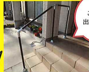
玄関ポーチに手摺の取付
